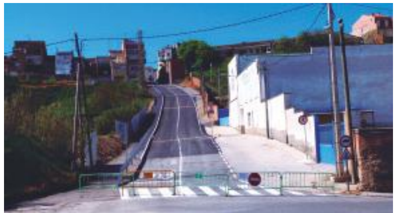
■ Obres de millora al carrer de la cavalleria
