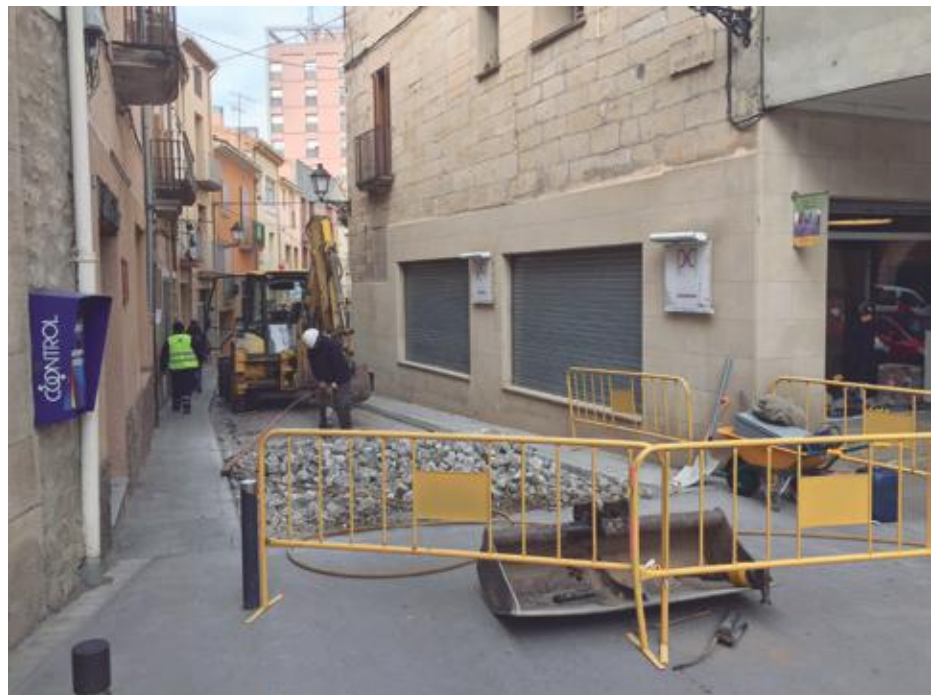
■ L'inici dels treballs d'arranjament del carrer Concepció Soler de les Borges
