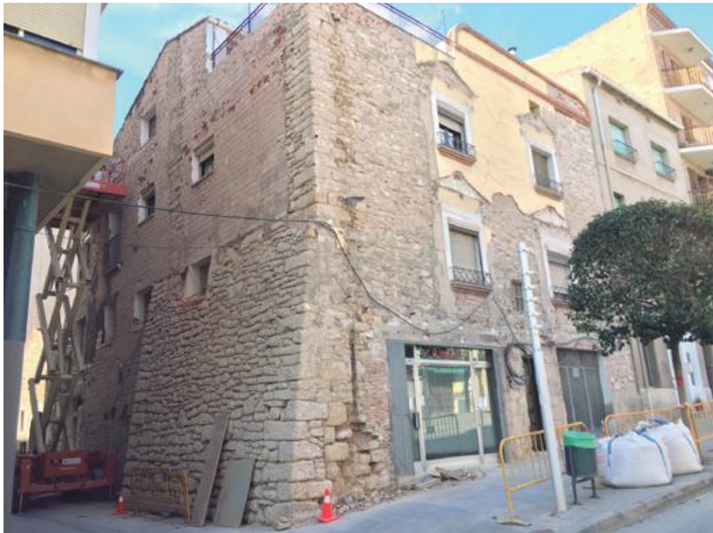
■ Una de les façanes que estan arranjant actualment al Centre Històric de les Borges Blanques
