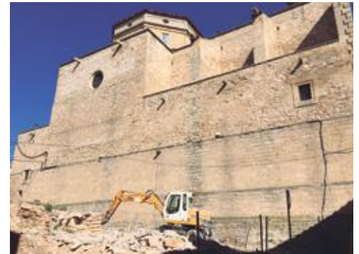
■ L'inici de l'obra del carrer Abadía de les Borges
