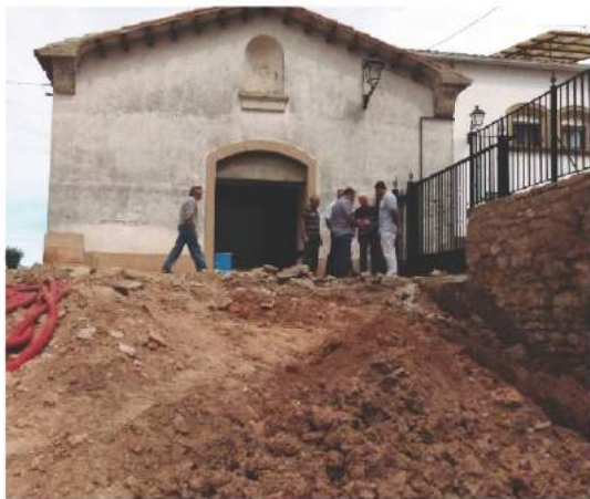
■ Visita de les autoritats i els veïns a les obres de la plaça Abadía
