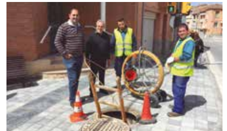
■ L'alcalde i el regidor amb els operaris que estan instal·lant la fibra òptica a les Borges
