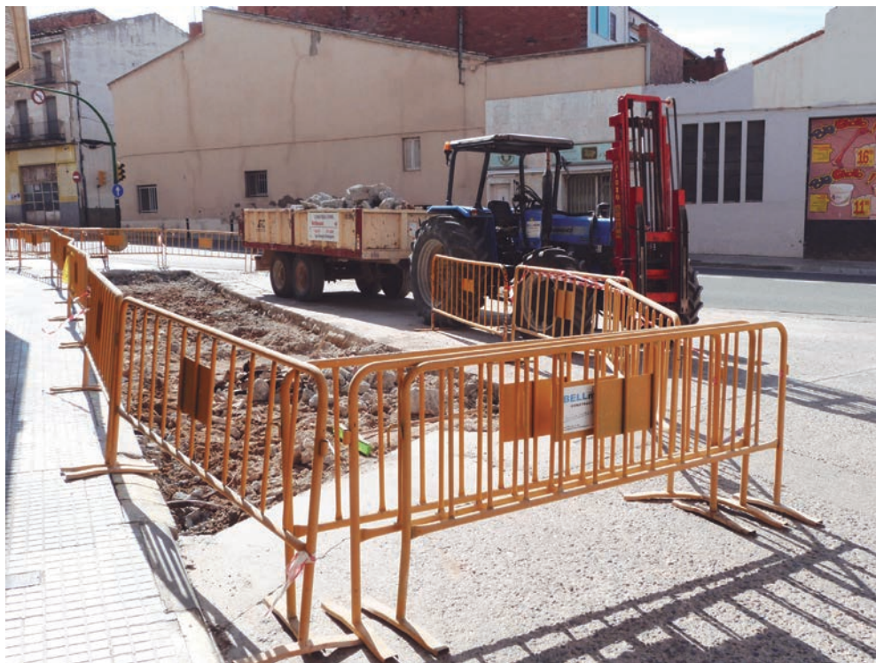
■ Una de les actuacions que s'ha dut a terme en la millora de vies públiques, l'urbanització de la placeta del Raval de Lleida
