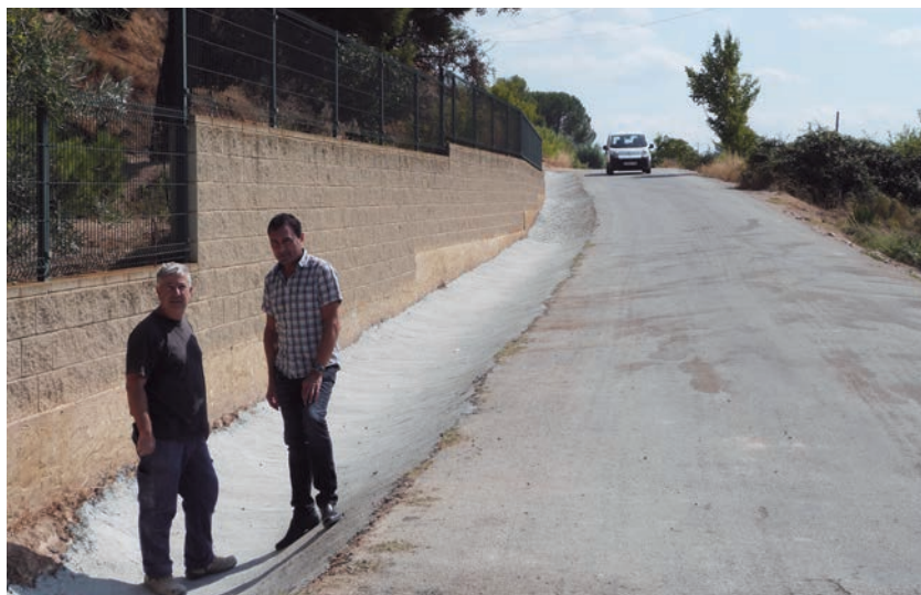
■ Visita final d'obra del regidor de Vies Públiques i el gerent d'urbanisme al tram afectat
